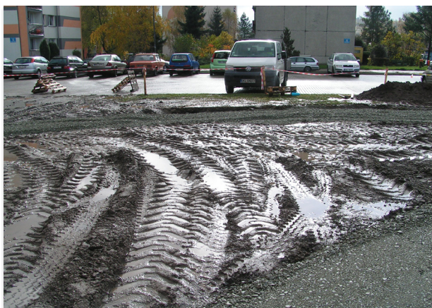
FOT. 29 Silnie ubita gleba na skutek przejazdu pojazdów mechanicznych
