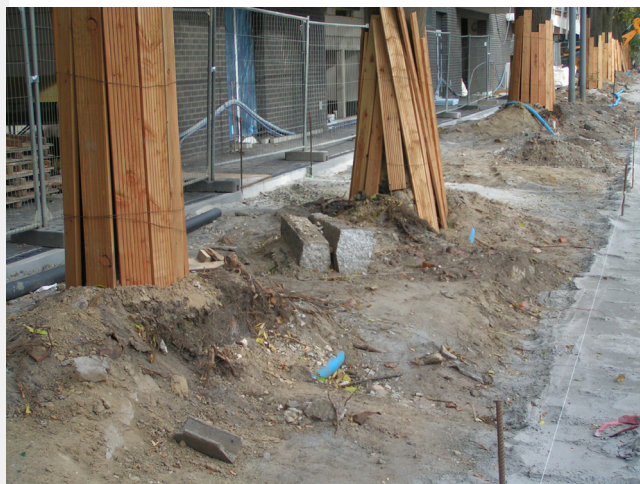
FOT. 40 Zniszczenia w obrębie systemu korzeniowego drzew (przykład niewłaściwie przyjętej metody zabezpieczenia drzew)
