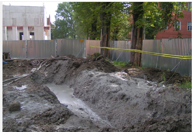
FOT. 43 Uszkodzenie systemu korzeniowego - poprzez wykopy i zanieczyszczenie gleby materiałami budowlanymi
